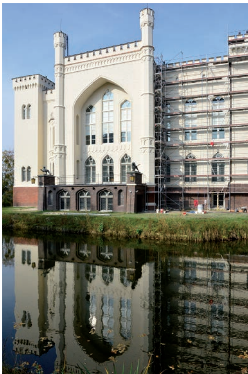
Elewacja południowa zamku w trakcie renowacji (2019 r.)
