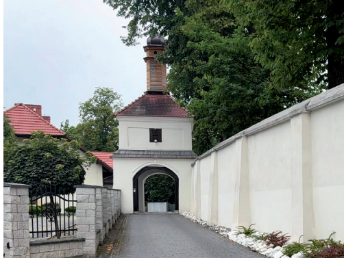
Remont murów przeprowadzony w 2021 roku, wpisany w szerzej zakrojone działania obejmujące m.in. drogę procesyjną (2020/2021), remont plebanii (2019), zakrystii (2018) czy prace przy poddaszu i fundamentach (2019). Fot. A. Badura, 2021
