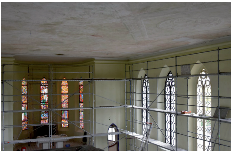
Wnętrze kościoła po wykonaniu podkładowej kryjącej warstwy malarskiej na ścianach. Fot. P. Celecka
