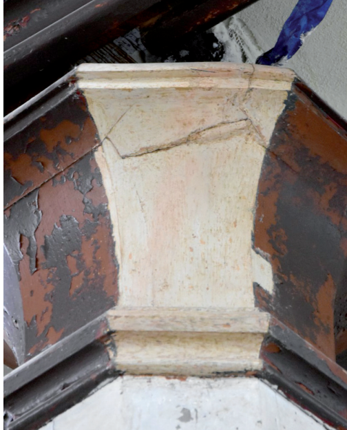
Kapitel kolumny podtrzymującej empore, odkrywka z oryginalną białą jednolitą kolorystyką. Fot. P. Celecka
