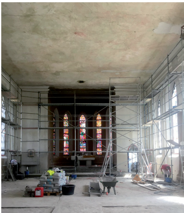
Wnętrze kościoła w trakcie remontu. Fot. P. Celecka
