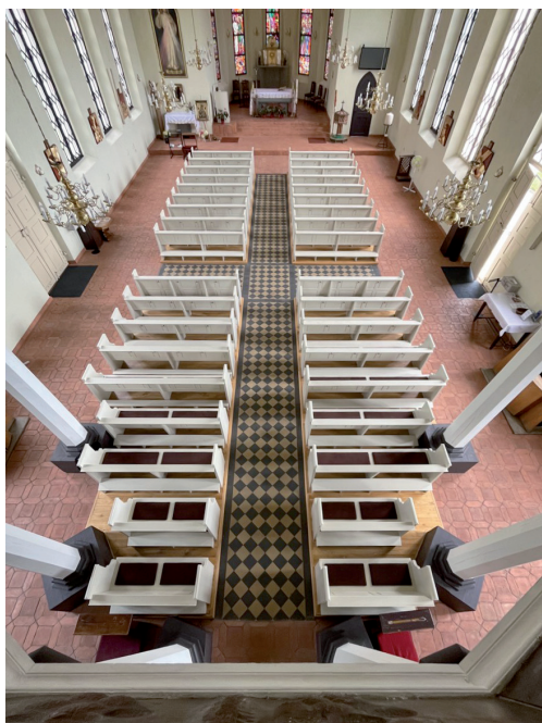
Wnętrze po remoncie, widok na część południowo-zachodnią kościoła (po lewej). Fot. P. Celecka
