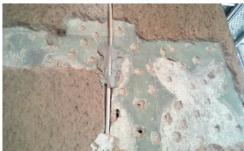
Odkrywka w prezbiterium ilustrująca pierwotną kolorystykę ścian kościoła, autor: mgr T. Filar
