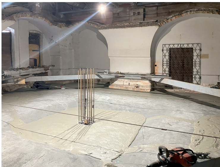
Na górze zdjęcia widać skalę zniszczeń stropu ceglanego, dół zdjęcia ukazuje proces odbudowy wraz z tymczasowymi wzmocnieniami budynku
