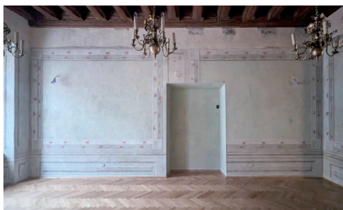
Sala Plenarna. Stan zachowania w trakcie i po konserwacji
