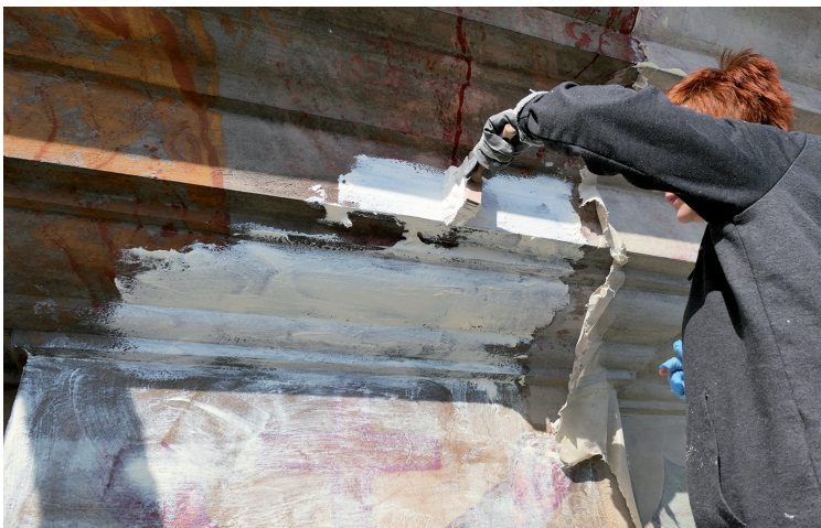
Fot. 2. Nakładanie pędzlem pasty lateksowej Remmers Arte Mundit na fragmencie elewacji
