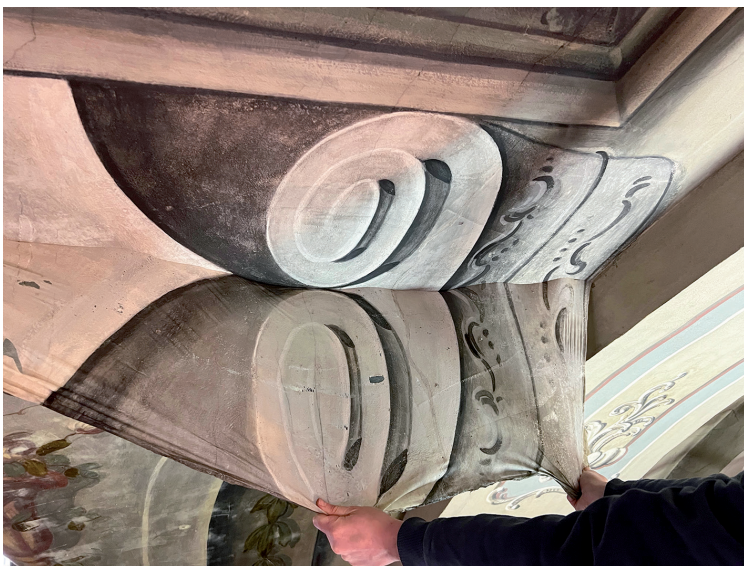
Fot. 3. Ściąganie błony lateksowej z zanieczyszczeniami i przemalowaniem ze sklepienia wewnątrz kościoła
