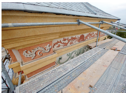
Dekoracja malarska elewacji w trakcie scalania kolorystycznego. Fot. M. Filip, 2021
