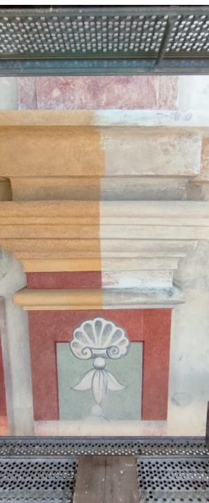
Próby scalania kolorystycznego polichromii. Fot. M. Filip, 2021
