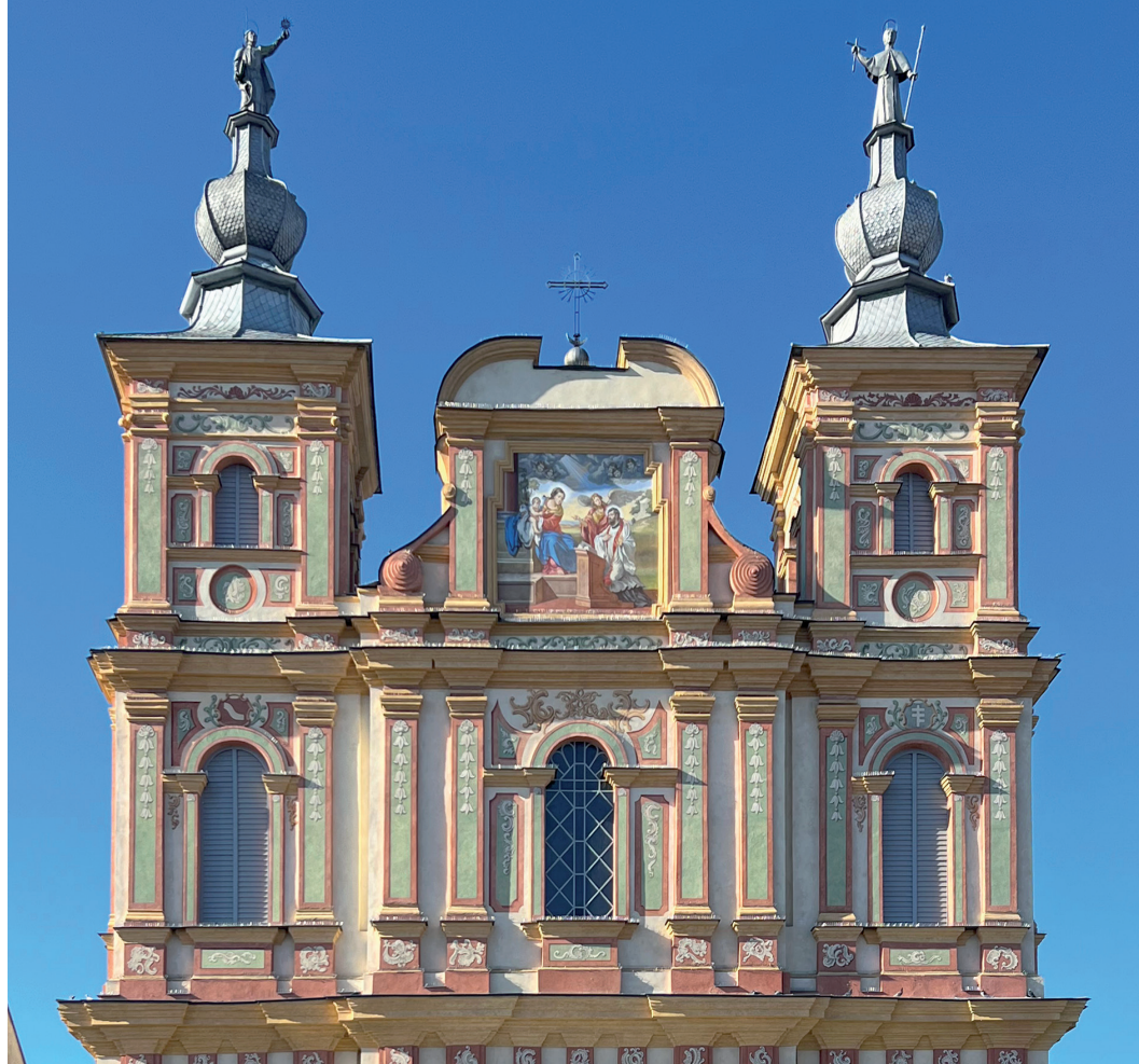
Elewacja frontowa kościół, końcowy etap prac. Fot. M. Filip, 2022
