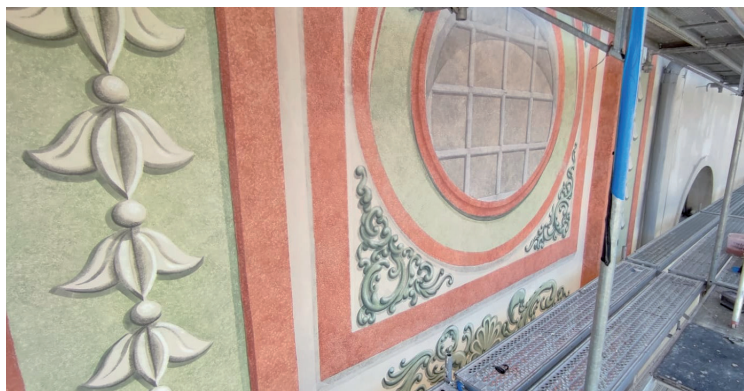
Dekoracja malarska elewacji w trakcie scalania kolorystycznego. Fot. M. Filip, 2021
