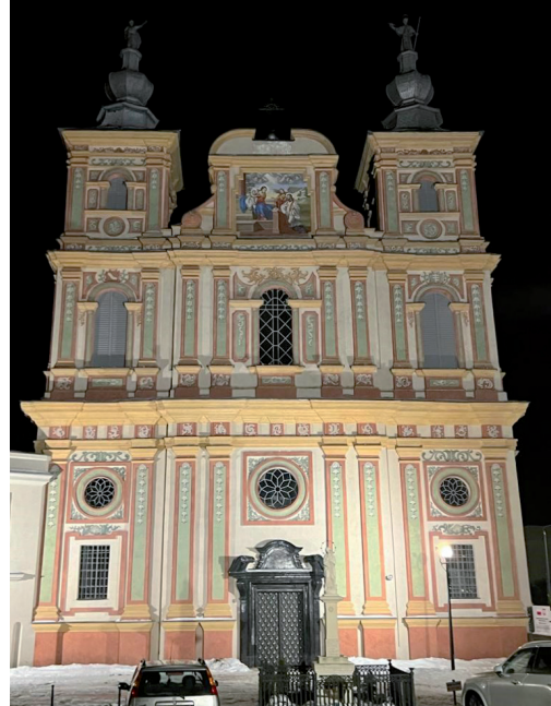
Elewacja frontowa kościoła po konserwacji, widok nocny. Fot. M. Filip, 2022
