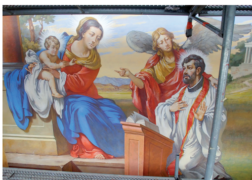
Obraz w zwieńczeniu fasady w trakcie prac. Fot. M. Filip, 2021
