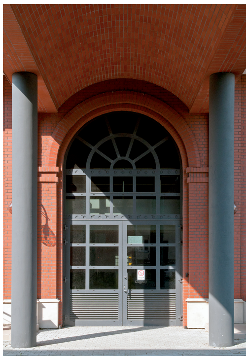
Budynek ozonowania pośredniego i filtrów węglowych MPWiK w Warszawie
