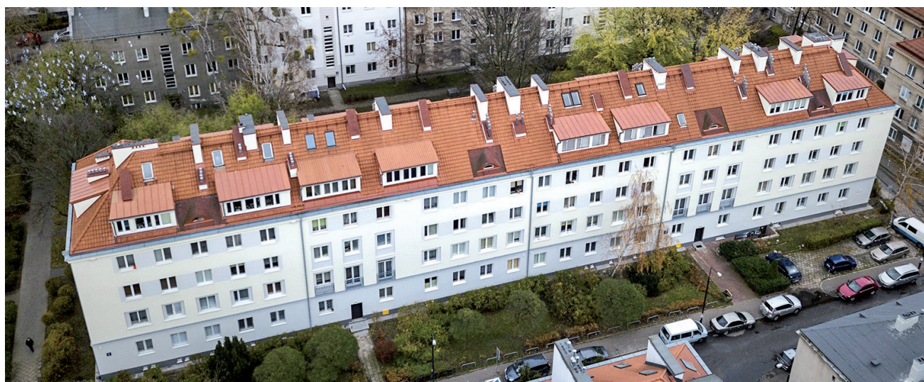
Budynek mieszkalny przy ulicy Tureckiej w Warszawie – widok lukarn dachowych
