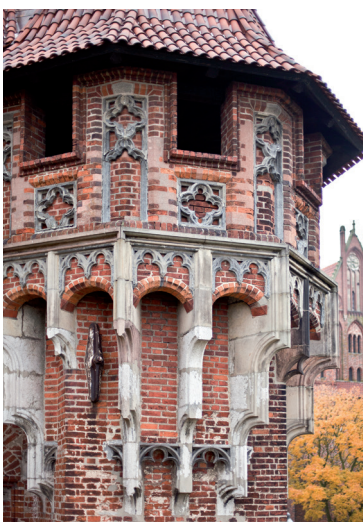
Fot. 20 i 21. Zamek Średni. Elewacja północna Pałacu Wielkich Mistrzów przed i po konserwacji
