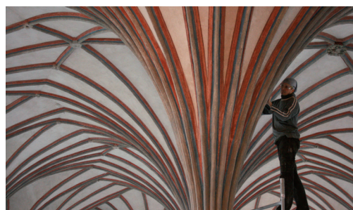
Fot. 13 i 14. Sklepienie Wielkiego Refektarza w 2006 r. Obok stan podczas restauracji w 2007 r.
