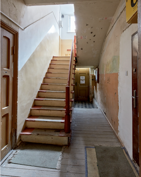
Klatka schodowa w kamienicy przy ul. Mazurskiej 5/5a; przed, w trakcie i po konserwacji
