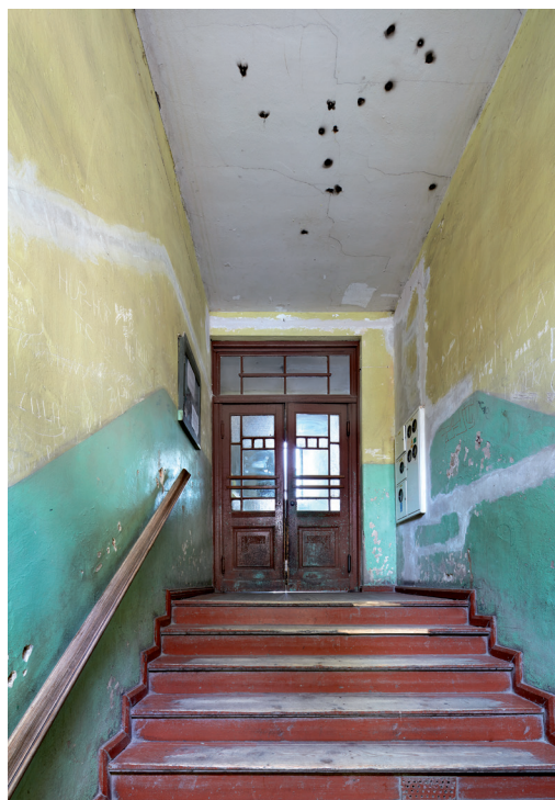
Sień w kamienicy przy ul. Warmińskiej 8; przed i po zakończeniu prac konserwatorskich
