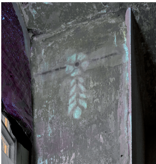
Klatka schodowa w kamienicy przy ul. M. Zientary-Malewskiej 3 – fragment dekoracji malarskiej w trakcie konserwacji – w świetle widzialnym i w promieniowaniu ultrafioletowym
