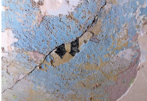
Widoczne ślady pierwotnego opracowania malarskiego w formie inskrypcji pod wtórnymi nawarstwieniami – stan przed pracami konserwatorskimi, 2018
