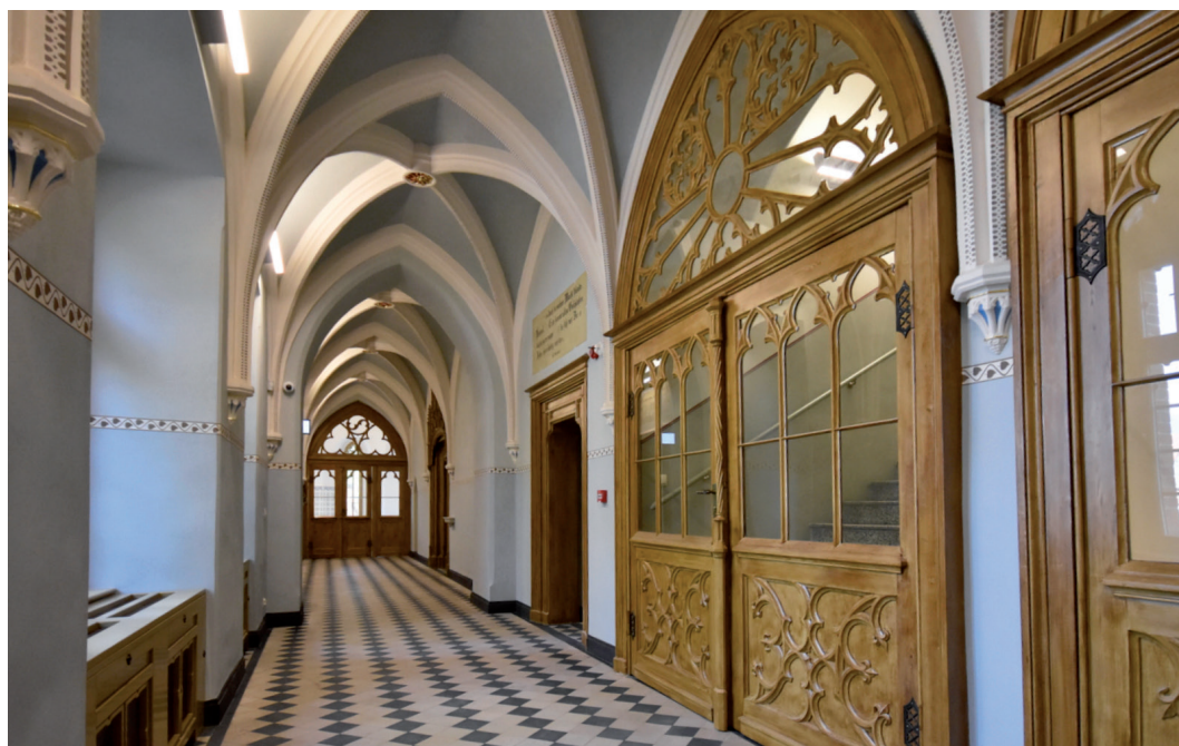
Korytarz parteru po stronie wschodniej – stan po pracach konserwatorskich, 2021
