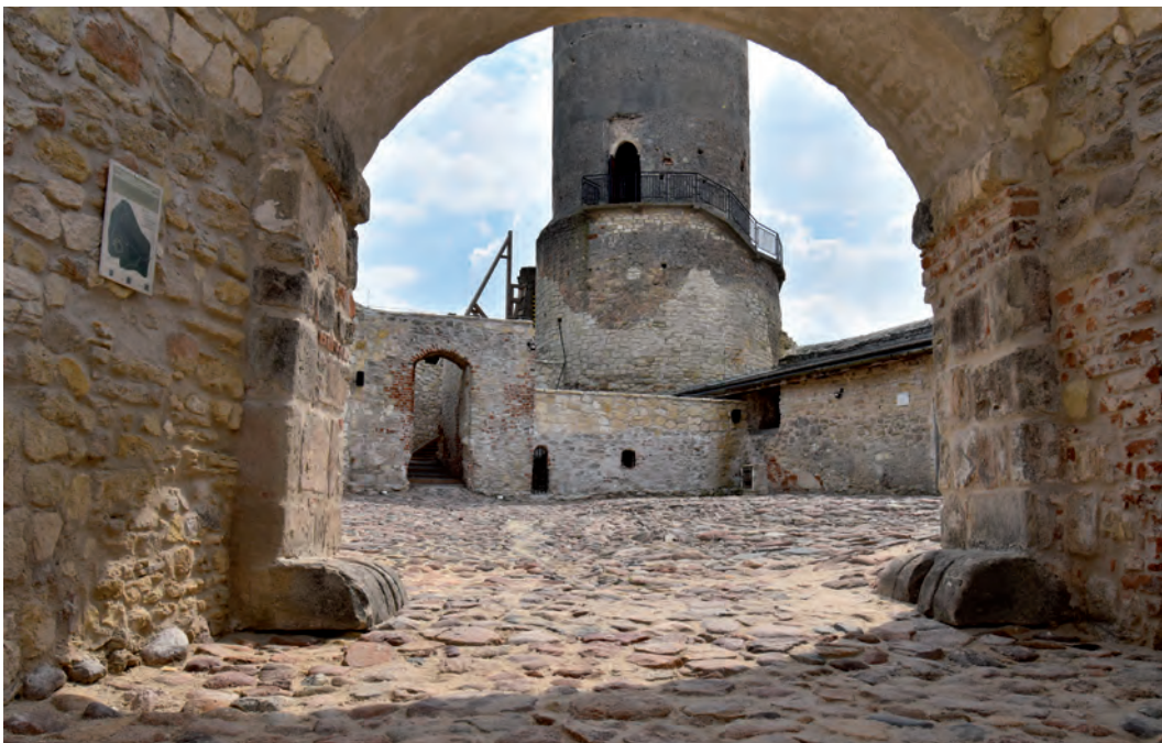
Ilża, zamek, stan w 2022 roku. Fot. UM w Ilży
