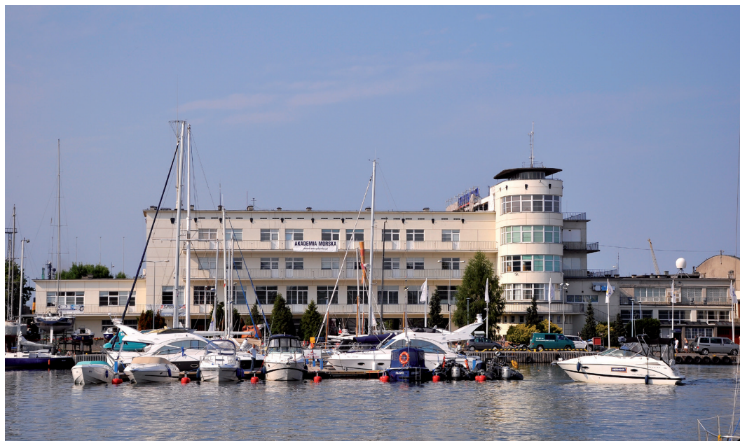
Dom Żeglarza Polskiego z 1937 roku w Gdyni. Budynki z okresu międzywojennego często są stosunkowo dobrej jakości technicznej. O ile nie są objęte ścisłą ochroną konserwatorską dopuszcza się w nich przekształcenia adaptacyjne
