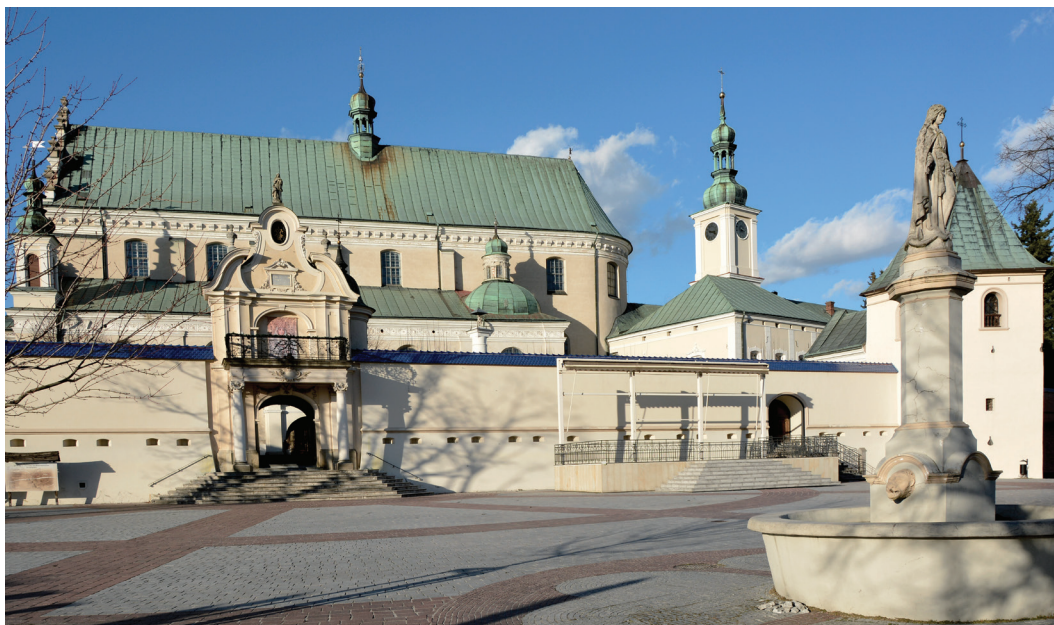
Zespół kościoła i klasztoru Bernardynów w Leżajsku wzniesiony w XVII w. W obiekcie tej klasy priorytetem jest zachowanie geometrii, proporcji, tradycyjnych technik budowy i remontu oraz stosowanie szczególnych materiałów i technologii
