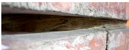
Rys. 2. Widok włókien PBO w spoinie wspornej przed aplikacją drugiej warstwy zaprawy
