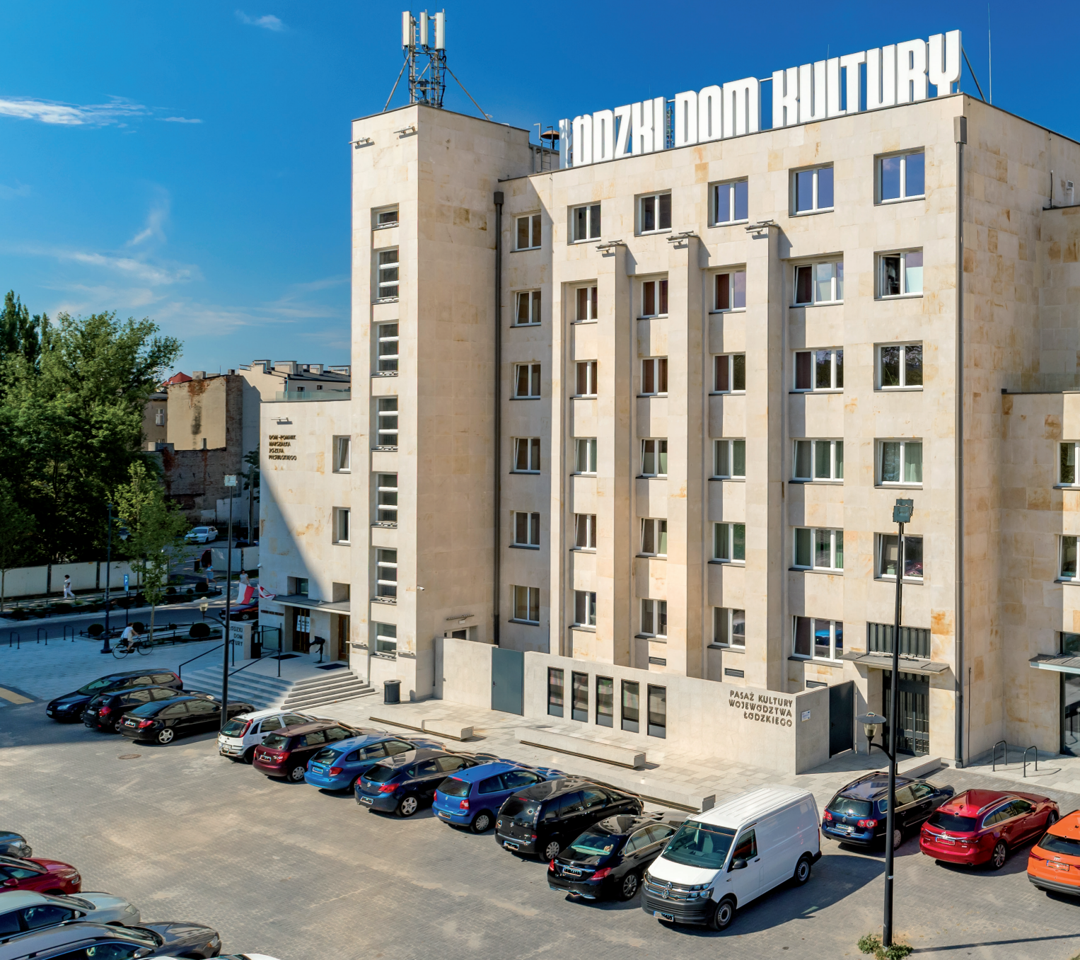
Fot. 3. Budynek ŁDK po zakończeniu prac
