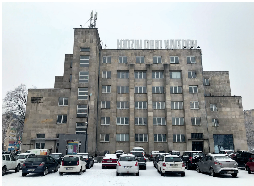
Fot. 1. Elewacja Łódzkiego Domu Kultury przed remontem
