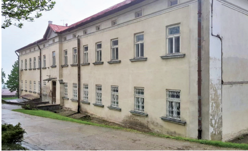
Dom Pielgrzyma – stan przed i po pracach renowacyjnych. Tu wykonano jedynie lokalne naprawy tynku wyprawą Optosan RenoPutz
