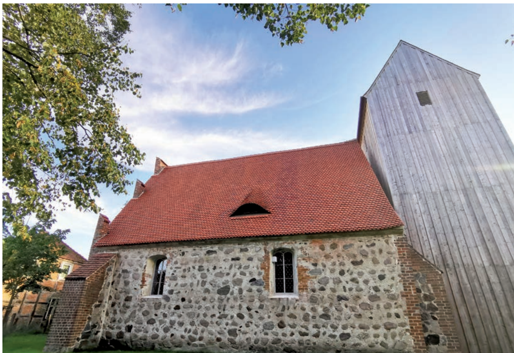
Kościół w Rossow, Niemcy – odtworzona przy użyciu nowej dachówki połącz dachu. Fot. Tomasz Nieruchalski – Heritage Roof Tiles Sp. z o.o.
