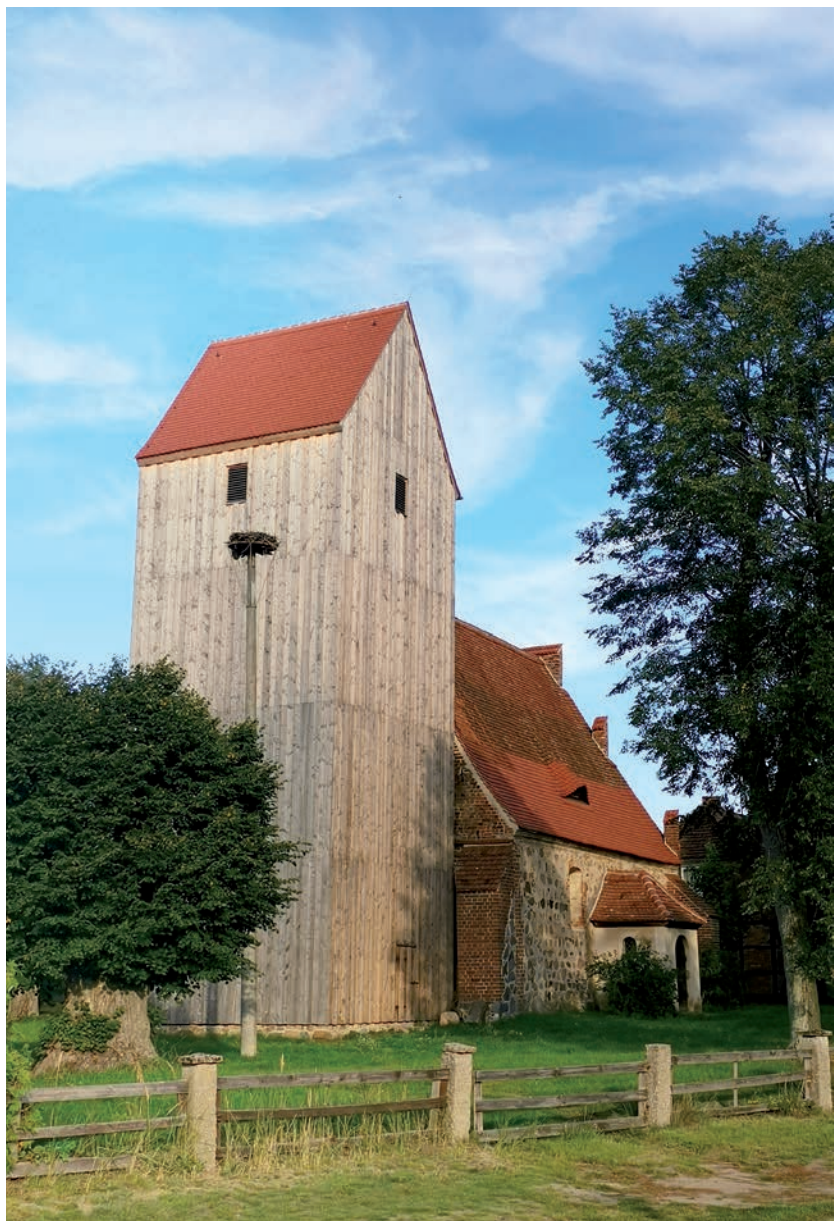
Kościół w Rossow, Niemcy po renowacji dachu przy użyciu dachówki karpówki produkcji FCB Ceramika. Fot. Tomasz Nieruchalski – Heritage Roof Tiles Sp. z o.o.
