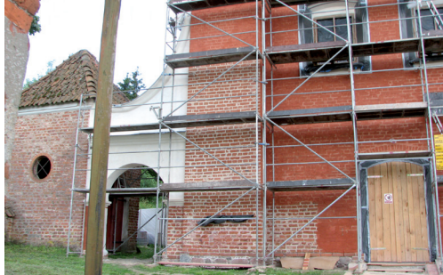
Elewacja w trakcie malowania. Laserunek zmienia intensywność koloru elewacji
