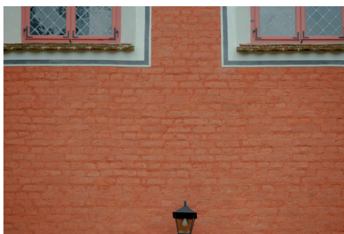
Opracowanie laserunkiem pozwoliło zachować zróżnicowanie i niuansy faktury lica muru
