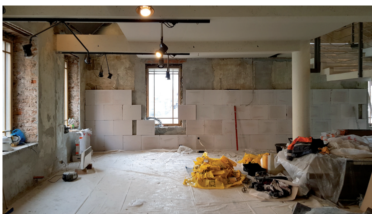
Fot. 3. Nowa warstwa ocieplenia wewnętrznego wykonana z płyt Multipor o grubości 10 cm
