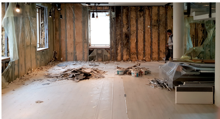
Fot. 2. Demontaż 20-letniego ocieplenia (2018 r.)
