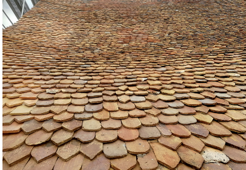
Fot. 3. Oryginalne pokrycie dachu Domu Solnego w Lubaniu zachowane in situ. Fot. M. Gąsior
