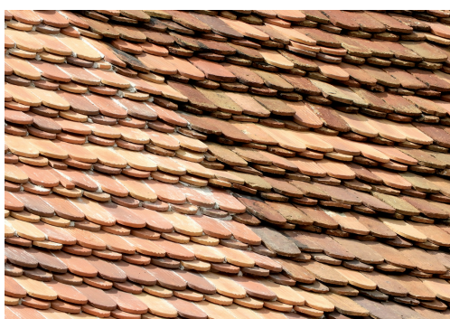
Fot. 6. Fragment połaci dachu Domu Solnego w Lubaniu. Po lewej stronie widoczna część zrekonstruowana, po prawej zachowana oryginalna połać z dachówki historycznej. Fot. T. Nieruchalski
