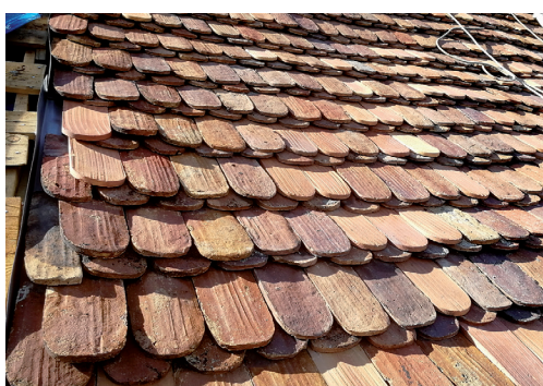
Fot. 5. Oryginalne pokrycie dachu Domu Solnego w Lubaniu zachowane in situ. Fot. M. Gąsior
