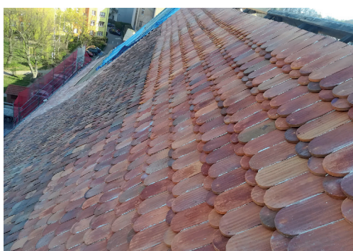
Fot. 7. Fragment połaci dachu Domu Solnego w Lubaniu, zrekonstruowanej z nowej dachówki wykonanej przez FCB Ostrzeszów. Fot. B. Malinowski
