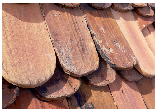
Fot. 4. Fragment połaci dachu Domu Solnego w Lubaniu – uzupełnienia ubytków pokrycia, wykonane ze zrekonstruowanych dachówek. Fot. T. Nieruchalski
