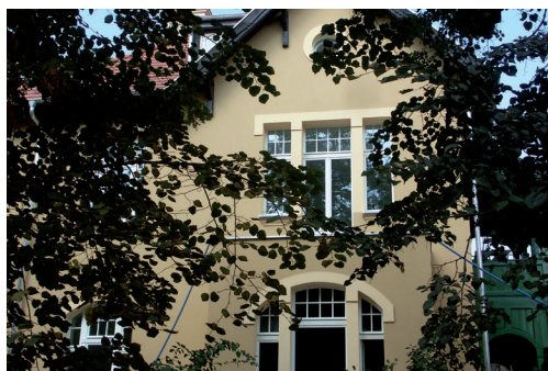
Fot. 2. Odtworzony pierwotny wygląd elewacji.
