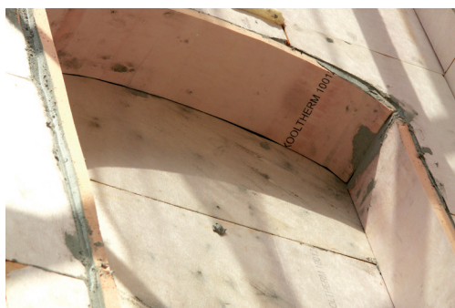
Fot. 1. Pianka rezolowa użyta do izolacji blendy.
