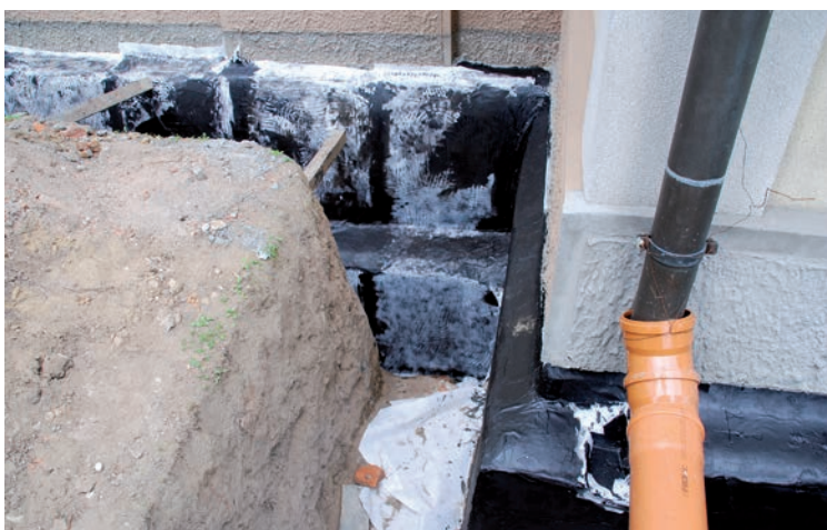
Widok ściany fundamentowej o silnie profilowanej powierzchni – wmurowane kamienie granitowe o znacznych rozmiarach.
