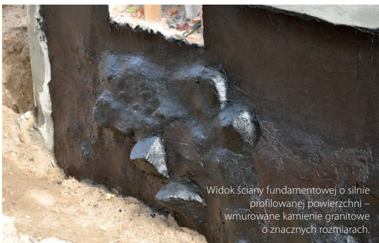
Izolacja bitumiczna COMBIDIC na powierzchni ściany fundamentowej rewitalizowanego obiektu.
