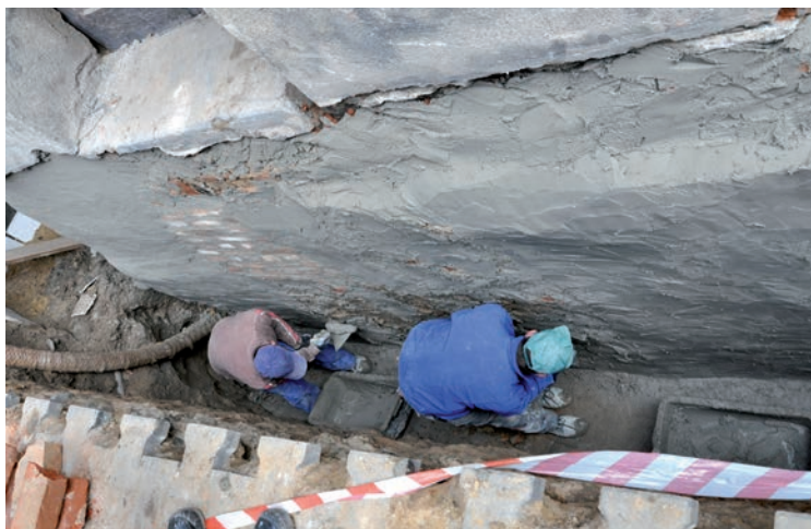
Wyrównywanie ściany fundamentowej z użyciem zaprawy mineralnej.
