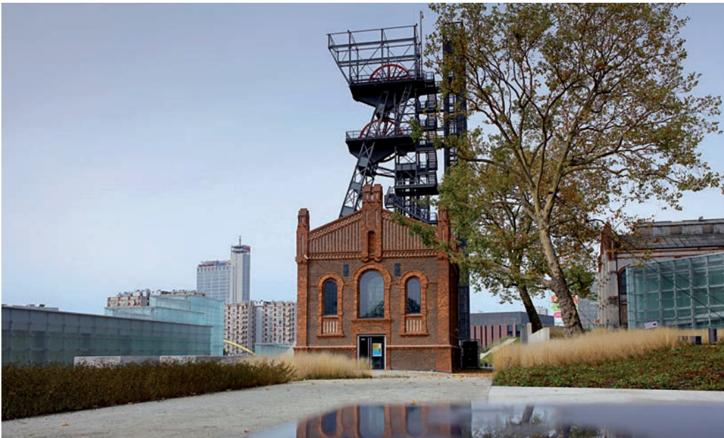
Budynki dawnej kopalni na terenie Nowego Muzeum Śląskiego w Katowicach wyremontowane przez firmę Konior FPB.
