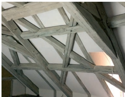
Pałac w Konarzewie. Fragment więźby dachowej zabezpieczony farbami KIM Lignosil.
