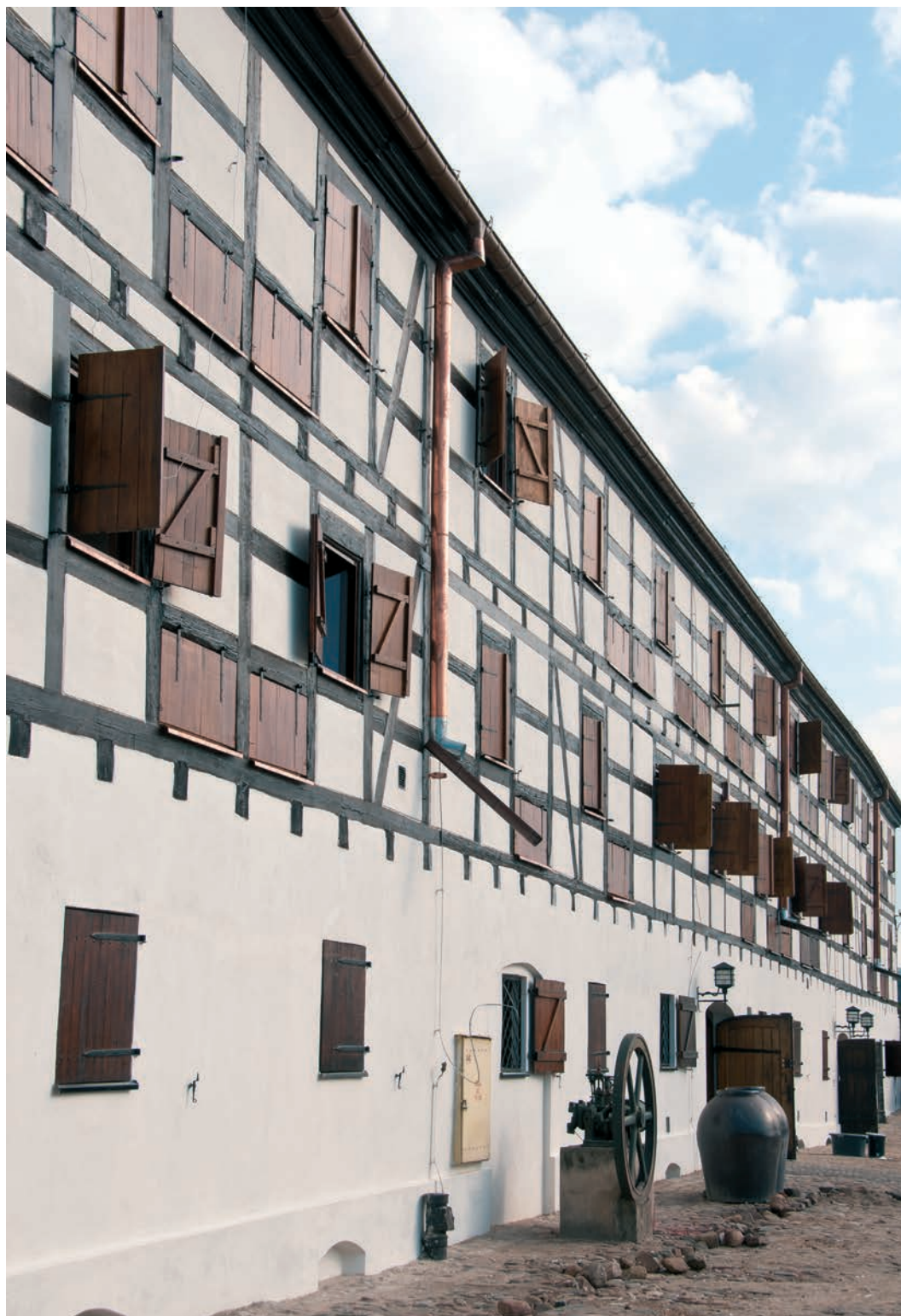
Odnowione mury szachulcowe gorzowskiego spichlerza ocieplono od środka za pomocą technologii Multipor.
