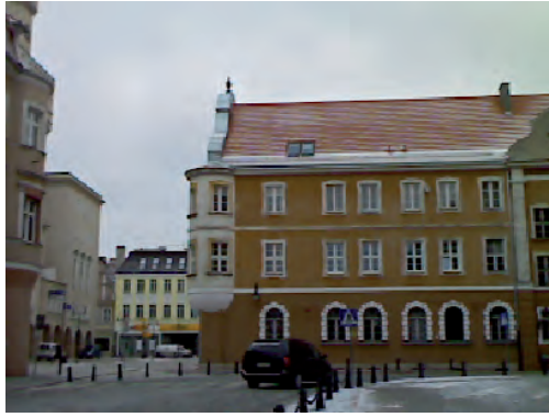
a) widok elewacji zachodniej budynku
