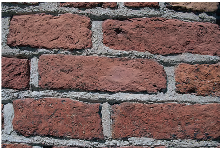
Wątek ceglany po konserwacji.
