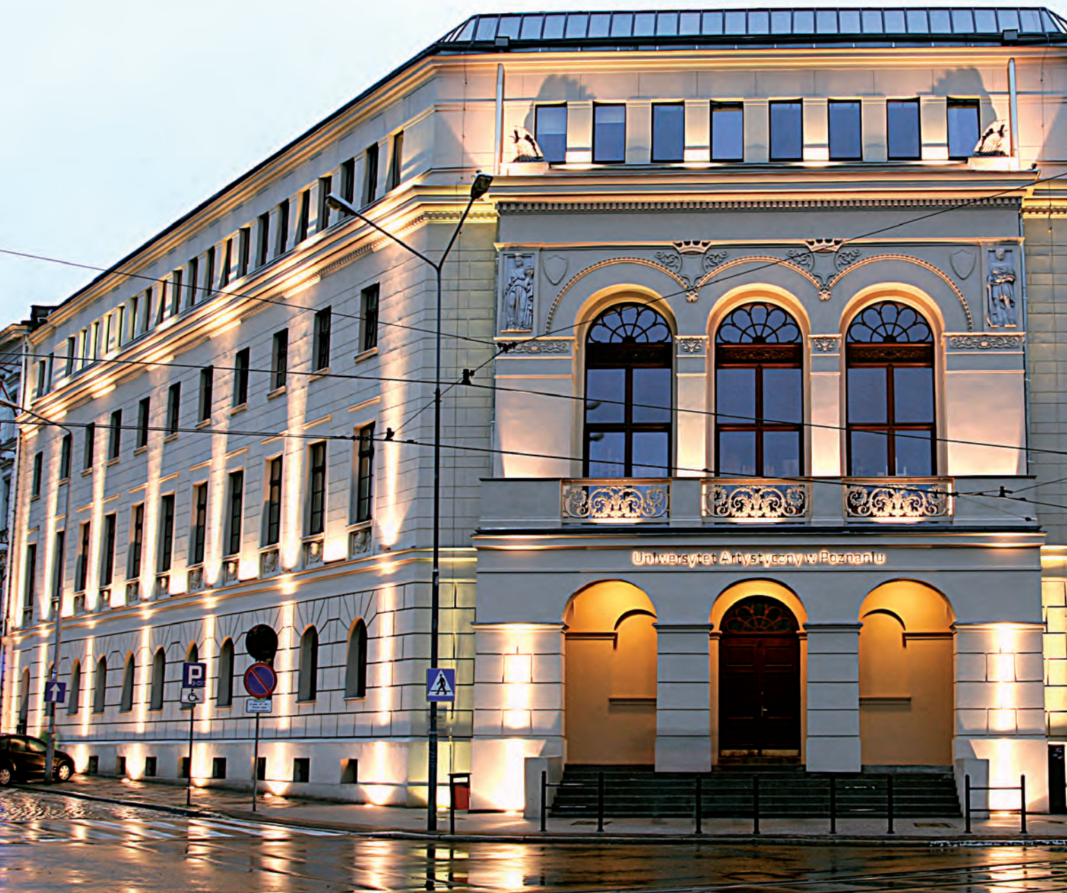
Uniwersytet Artystyczny, Poznań, al. Marcinkowskiego 29 Nagroda Główna w Konkursie Baumit Fasada Roku 2012 w kategorii „Budynek po renowacji”
