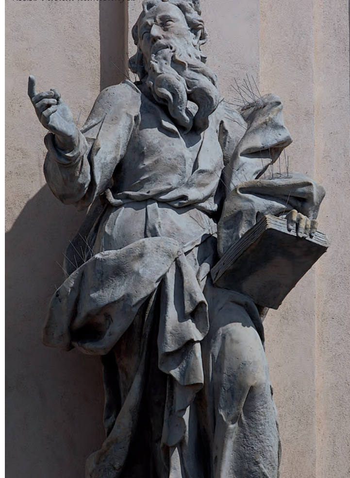
Figura św. Joachima z fasady warszawskiego kościoła Wizytek po konserwacji, podczas której wykorzystano laser do oczyszczania rzeźb i detali kamiennych
