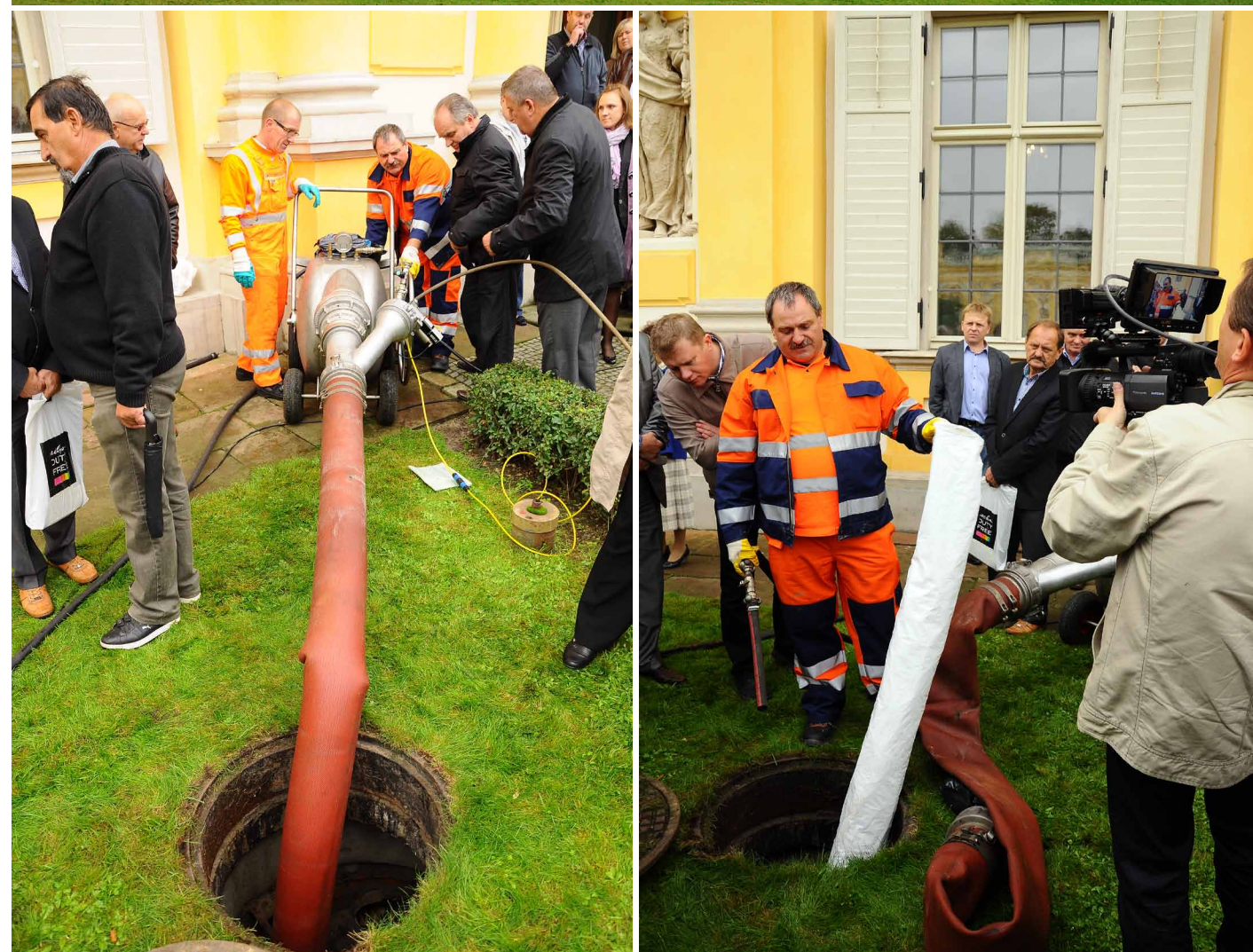
„Jubileusz w terenie” kontynuowany był m.in. poprzez pokaz nowatorskiej bezwykopowej metody rękawem Aarsleff z zastosowaniem światła LED.
