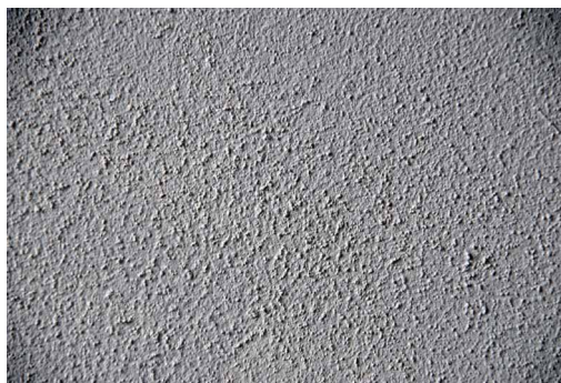
Pałac Pod Blachą, faktura farby podkładowej KEIM Soldalit-Grob.
