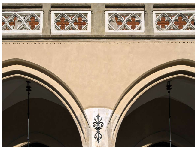
Stan po konserwacji. Laserunkowe warstwy malarskie.
