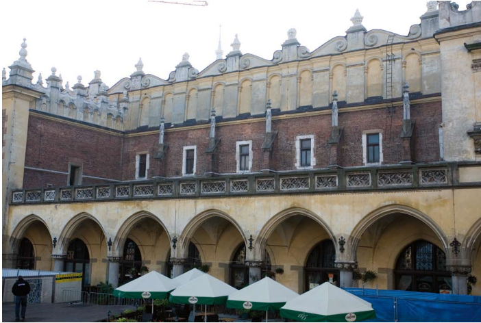
Fragmety elewacji zachodniej przed konserwacją, zły stan tynków, kamieniarki i wątków ceglanych.
