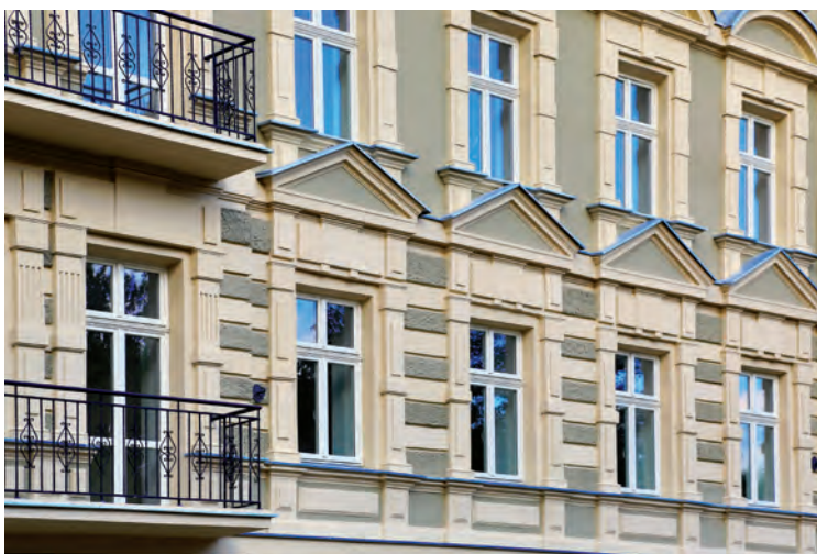
Kamienica przy ul. Kilińskiego 84 po renowacji – kolorystyka ustalona na podstawie badań wykonanych na etapie wykonawczym.
