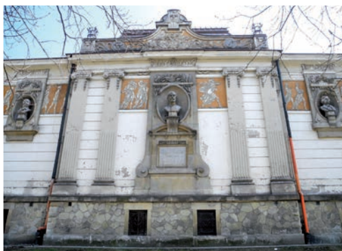
Elewacja od strony Plant przed konserwacją. Fot. archiwum Art Forum.
