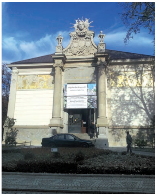
Elewacja frontowa po konserwacji. Fot. archiwum Art Forum.
