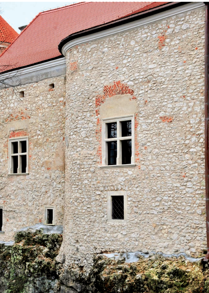
Elewacja północna przed i po renowacji. Silna korozja na elewacji spowodowała konieczność wprowadzenia znacznej ilości nowych spoin naprawczych, dopasowanych kolorem i fakturą bezpośrednio na placu budowy z użyciem Optosan TrassKalk. Fot. Archiwum AC Konserwacja.
