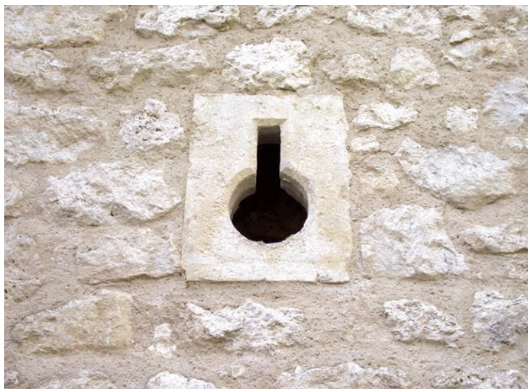
Fragment murów po renowacji. Kolor i faktura dopasowane do oryginalnej zaprawy, na bazie Optosan TrassKalk, bezpośrednio na placu budowy.
