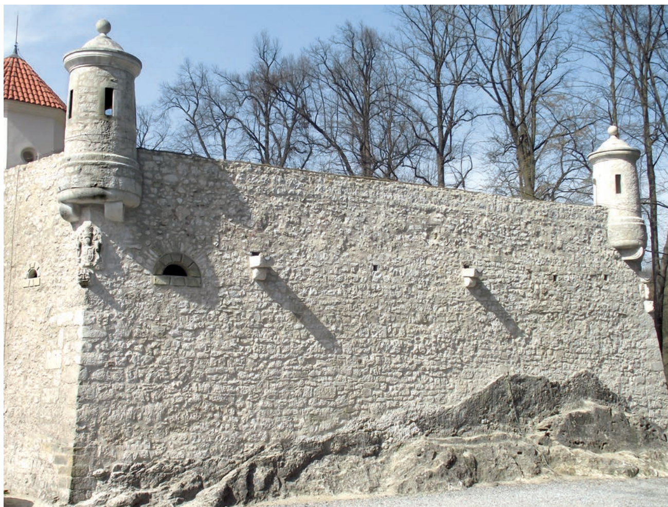
Bastion północny murów zamku – stan po konserwacji.
