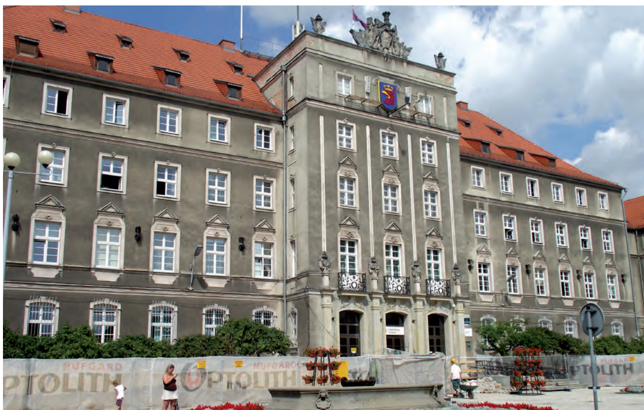
Elewacje budynku Urzędu Miejskiego przed renowacją. Wtórne, szare tynki wapienno-cementowe całkowicie skrywają pierwotną fakturę i kolorystykę elewacji.
