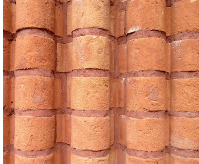
Zbliżenie wątku ceglanych ścian Czerwonego Ratusza – specjalnie dobrana w ciemno-czerwonym kolorze fabryczna spoina Optosan TrassFuge.
