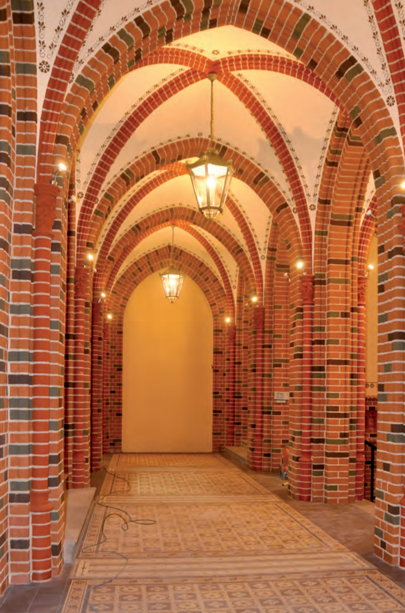
Czerwony Ratusz – wnętrza po renowacji. Widoczna jasna kolorystyka spoin Optosan MFM zakładanych maszynowo. Fot. Konsart Szczecin.
