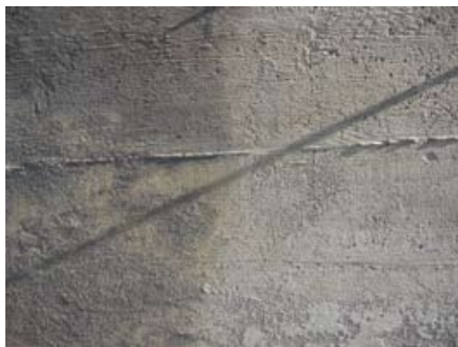
Fot. 8 – Fragment oczyszczonej powierzchni betonu
