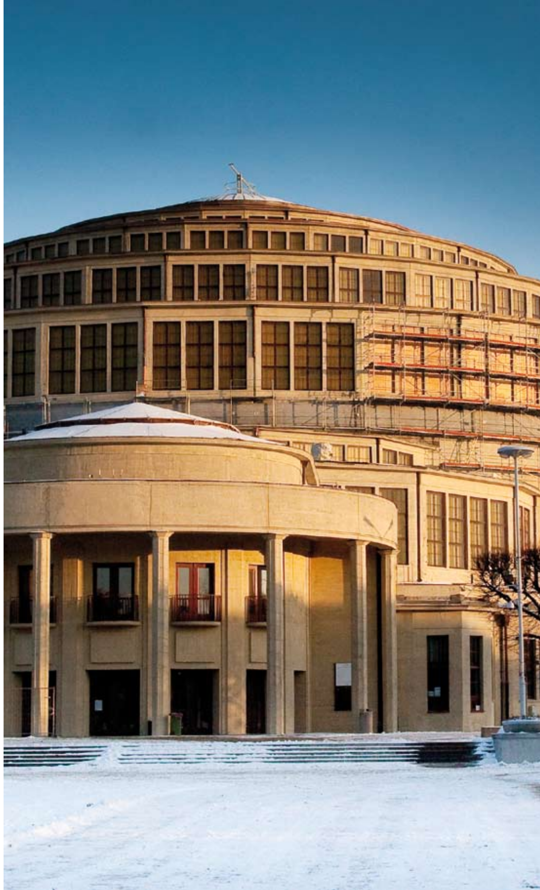
Fot. 14 – Elewacja w końcowej fazie remontu, grudzień 2009
