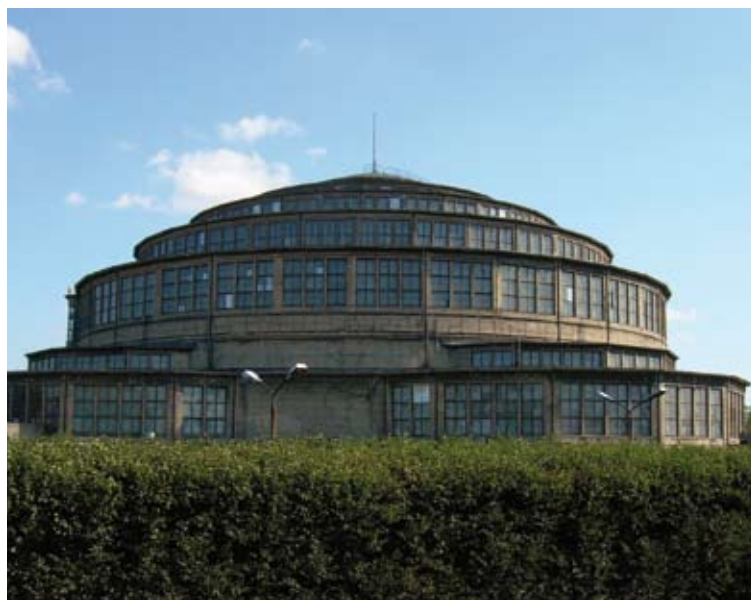
Fot. 1 – Elewacja przed remontem, październik 2007
