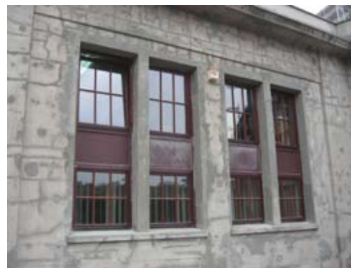
Fot. 9 – Powierzchnia betonu po wykonaniu napraw
