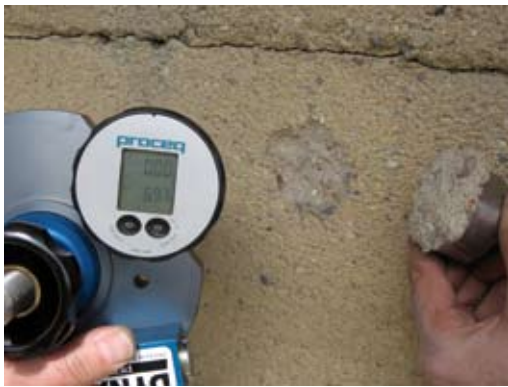
Fot. 10 – Badania przy- czepności powłok metodą pull-off
