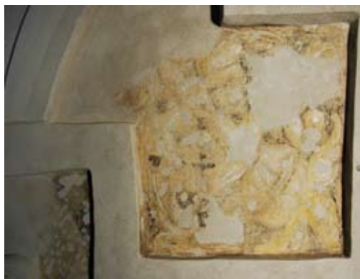
Pole sklepienne z relikwiami XVI-wiecznej dekoracji; stan po oczyszczeniu i konserwacji technicznej
