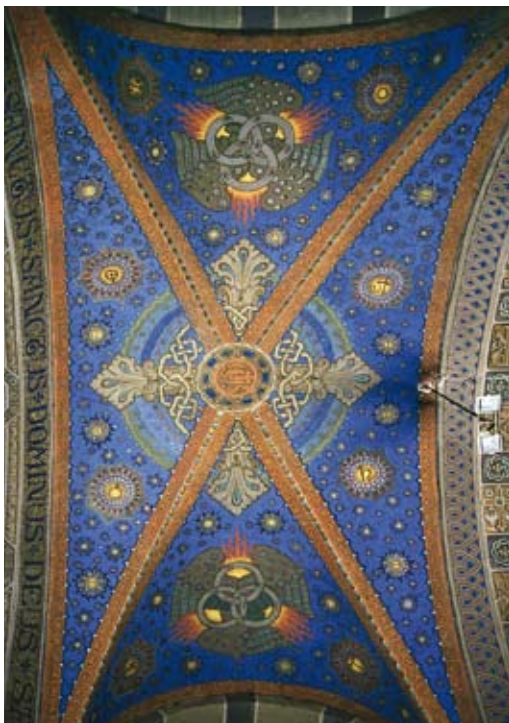
Kościół w Drzycimiu – widok na sklepienie
