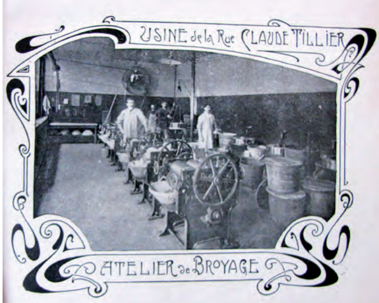
Zaczątkiem debaty na temat jakości farb była maszynowa produkcja farb, jak choćby w przedstawionej tu ucieralni Bourgeois Aîné w Paryżu. Źródło: Bourgeois Aîné, Catalogue Illustré: Couleurs fines & matériel pour l'aquarelle, la gouache, la miniature, le pastel [etc.], Paris, 1906.
