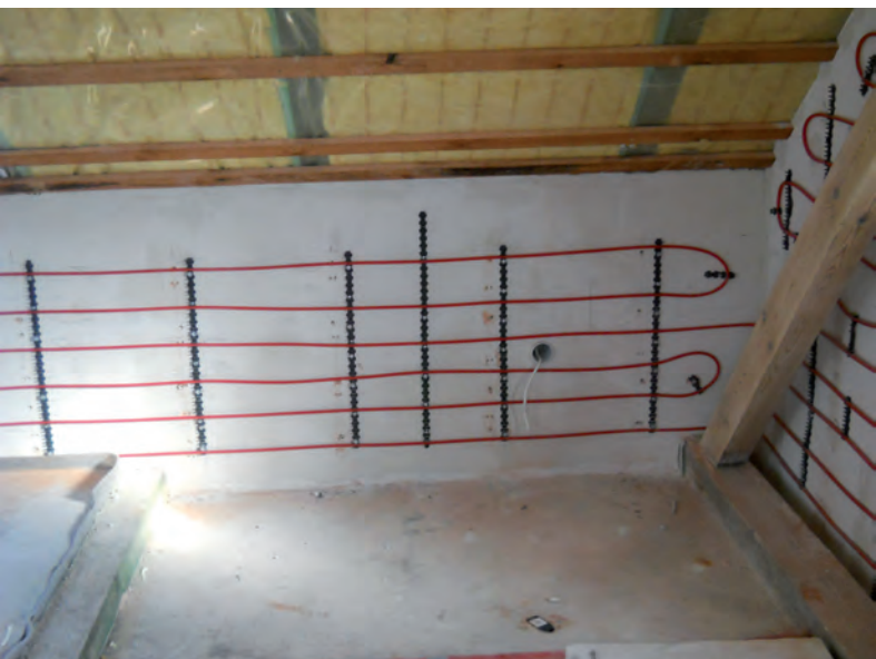
Rys. 11. Ogrzewanie ściennie na płytach Multipor.
