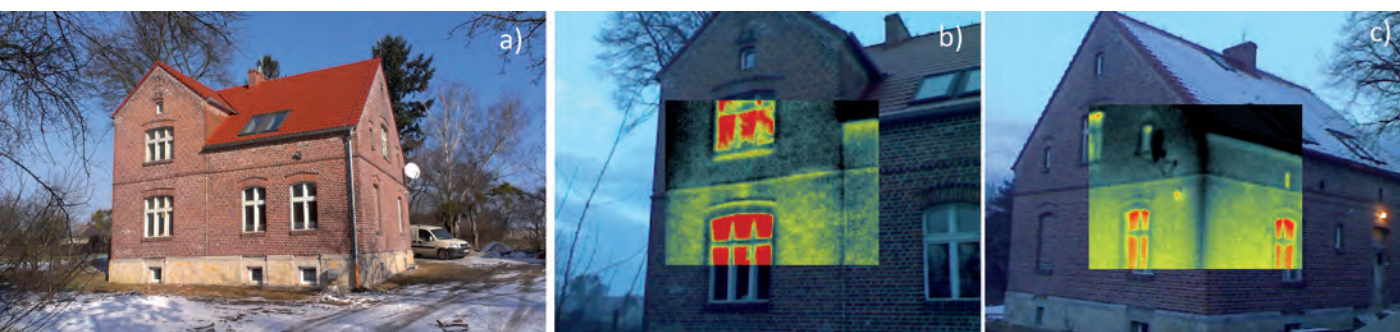
Rys. 1. 85-letni budynek mieszkalny: a) widok, b) i c) widoczne efekty ocieplenia górnej kondygnacji.
