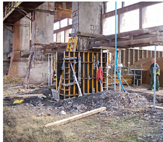
Widok szalunku przygotowanego do betonowania przy odbudowie słupów.
