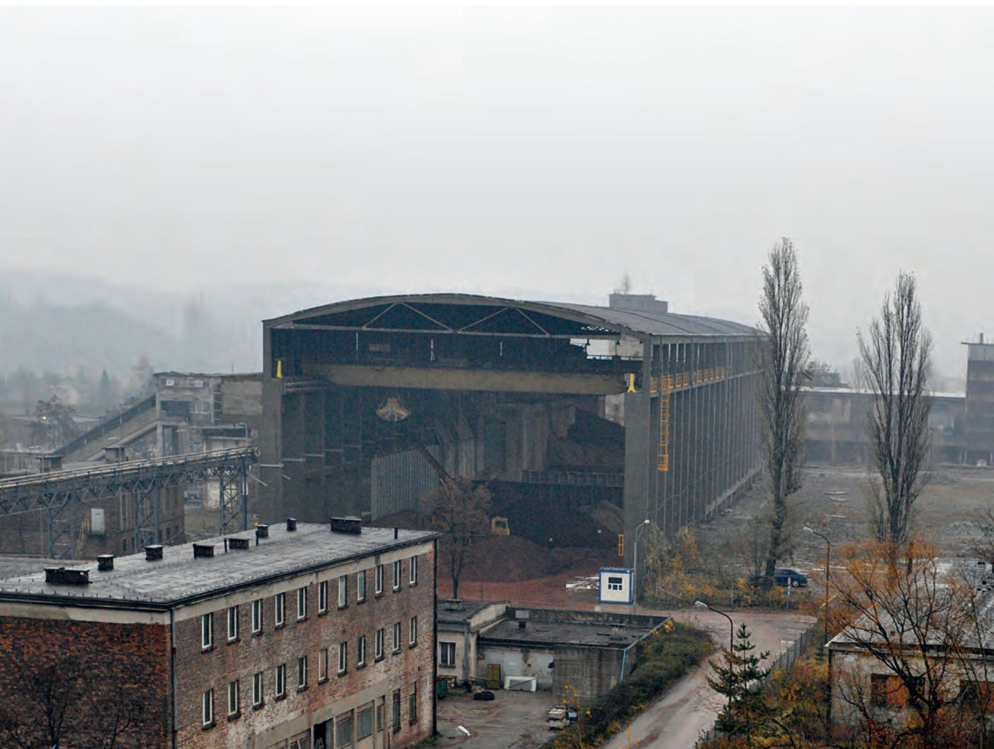
Widok na Magazyn Surowca Cementowni Górka.
