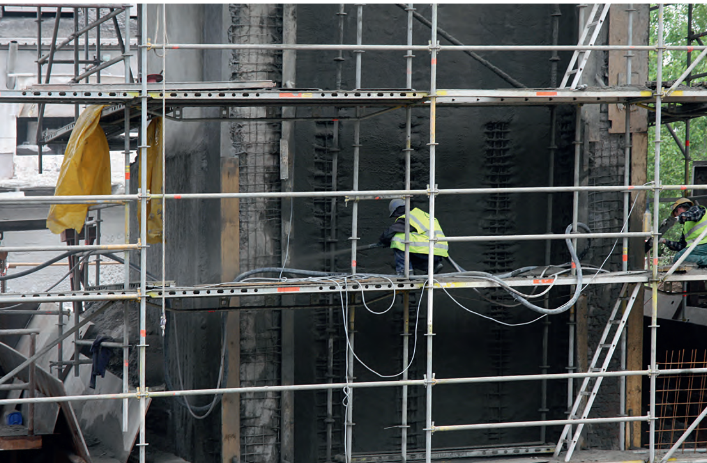
Reprofilacja zaprawami natryskowymi.
