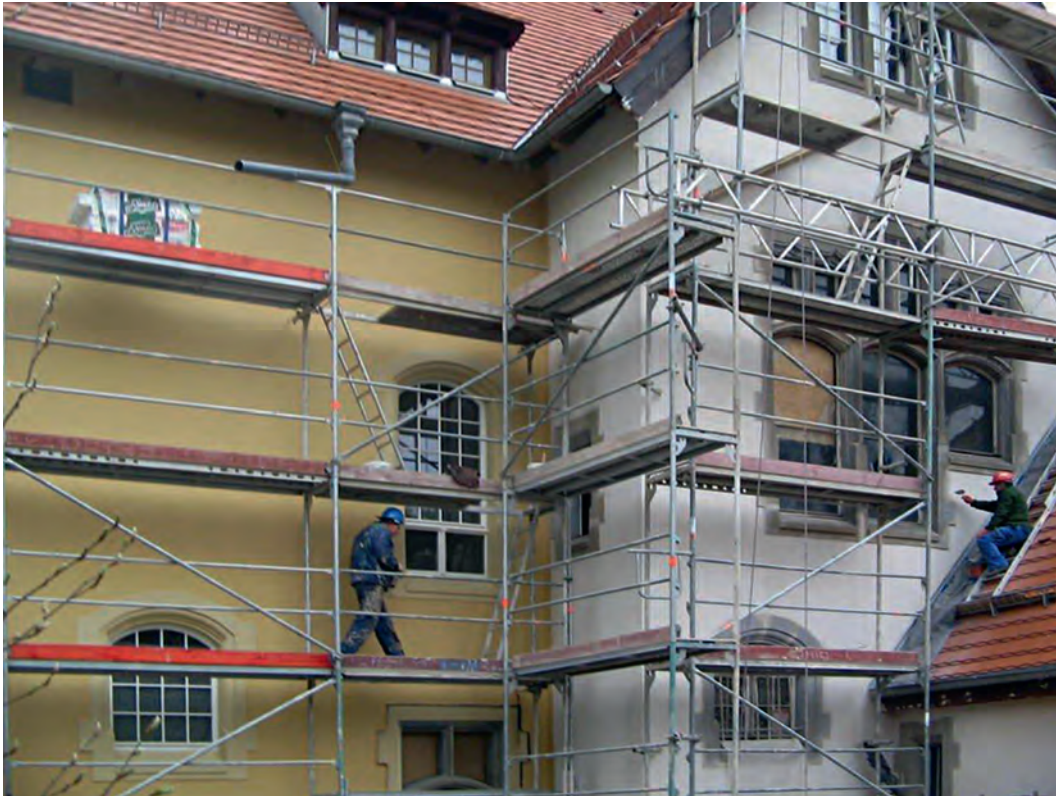
Elewacja od strony ogrodu, podczas wykańczania.
