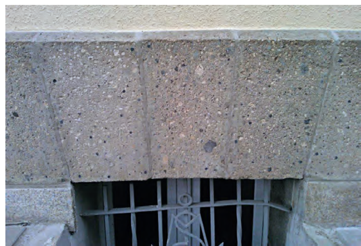
Cokół po uzupełnieniu – odtworzeniu brakujących elementów.
