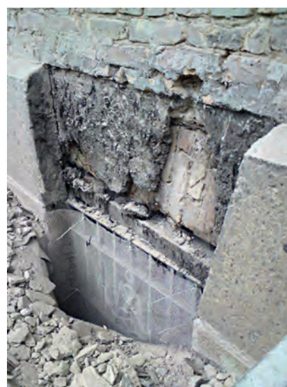
Cokół po uzupełnieniu – odtworzeniu brakujących elementów.
