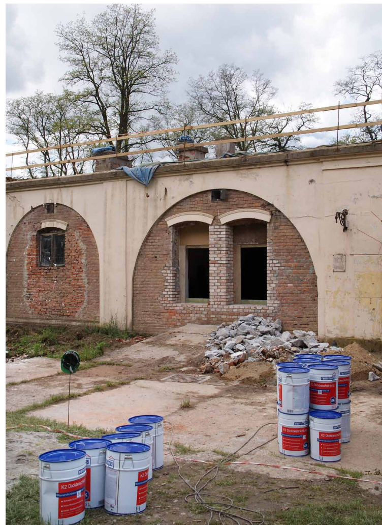
Fort VIII „Łętownia”, hydroizolacja.
