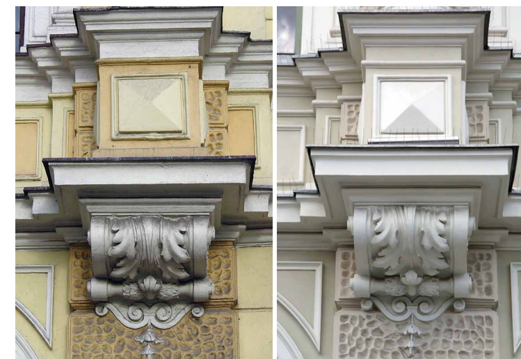
Przemyśl dworzec PKP, detal przed i po renowacji.
