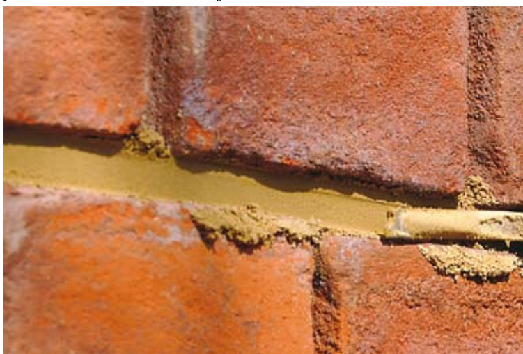
Konserwacja elewacji ceglanych jest bardzo czasochłonna, ale ostatecznym efektem tych prac jest świeży i bardzo efektowny wygląd muru.
