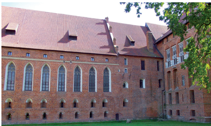
Ściany zachodnia i północna Zamku Średniego po renowacji w 2010 r.
