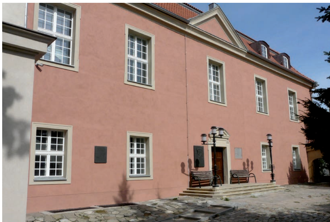
Elewacja budynku Raczyńskiego zrekonstruowana w tynkach barwionych w masie Optosan TrassFeinputz.
