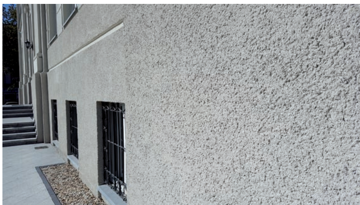
Zbliżenie cokołu elewacji gimnazjum. Charakterystyczna ostroziarnista struktura tynku. Dzięki „cyklinowaniu” powierzchni uzyskano równą, jednolitą strukturę bez przebarwień i śladów narzędzi.
