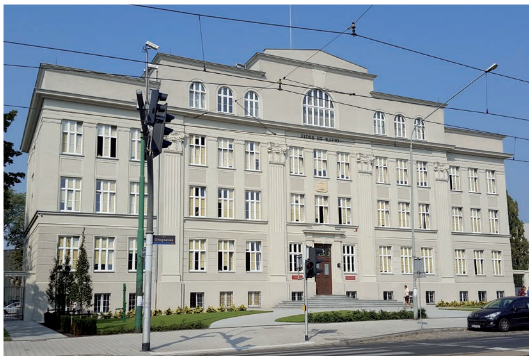
Publiczne Gimnazjum im. Św. Stanisława Kostki – elewacja główna po pracach renowacyjnych z użyciem wypraw tynkarskich Optosan KratzPutz.
