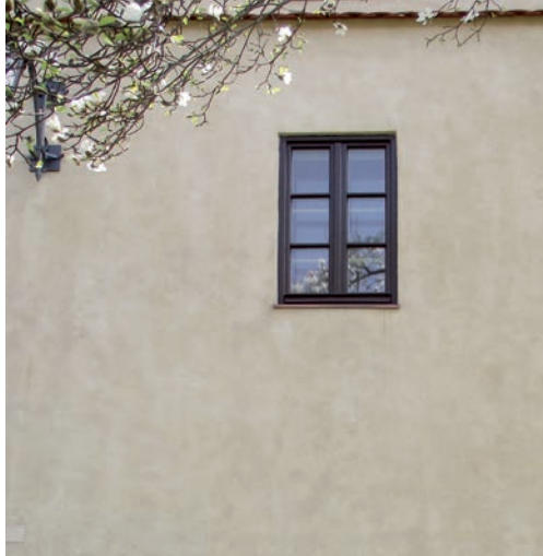
Zbliżenie elewacji Muzeum Archeologicznego w Krakowie. Powierzchnia tynku barwionego zacieranego na gładko. Widoczne charakterystyczne dla tej techniki „chmurki” – pozostawione ślady pracy narzędzi tynkarskich.
