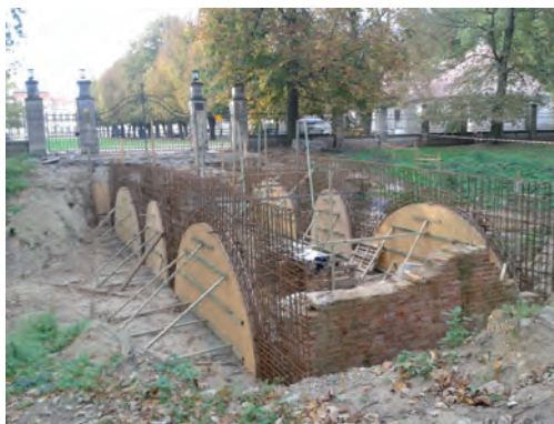
Zbrojenie ścian
