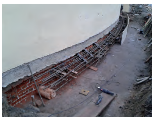
Zbrojenie oczepu żelbetowego zewnętrznego po obwodzie ściany
