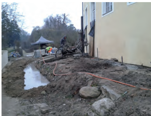
Palowanie po obwodzie ściany zewnętrznej
