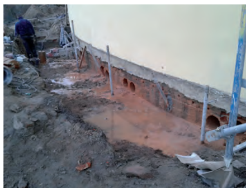
Otwory \varnothing 250 po obu stronach mikropali
