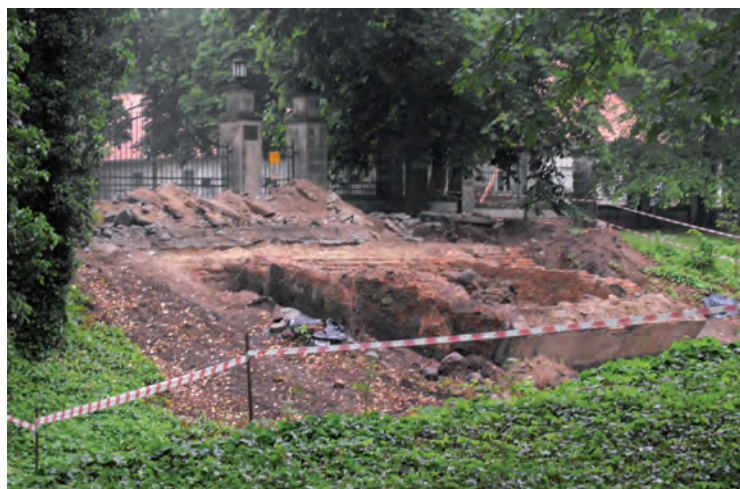
Odslonięte przyczółki zabytkowego mostka. Fot. Radosław Osysko
