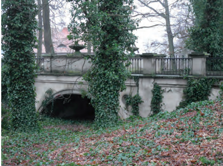
Mostek z lat 60. ubiegłego wieku. Fot. Piotr Domagała
