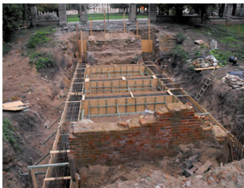
Szalowanie ław fundamentowych z obejmami historycznych filarów
